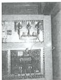
รูปที่ 4.11 เปิด Safety Interlock ไปตำแหน่ง on
